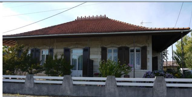
**Particularités :** Maison composée d'un corps principal rectangulaire, flanqué de deux tourelles désaxées en arrière. Les tourelles sont dans la continuité de la galerie qui entoure le bâti principal. Les toitures sont à 2 croupes, composée de tuiles de Marseille, est surmontées d'une crête de faitage en terre cuite. La galerie à colonnettes en fonte s'insère sous la rupture de pente du toit.
