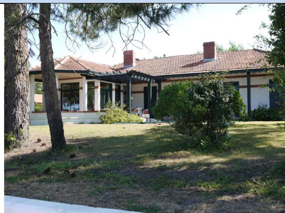
**Particularités :** La façade littorale comporte un perron en avancée latérale. La toiture est recouverte de tuiles de Marseille. Les souches de cheminée sont composées de briques. La partie supérieure de la façade est soulignée par des bandeaux de brique. Aucune clôture ne sépare le jardin de la plage. Le jardin compte quelques pins maritimes participant au front boisé.
