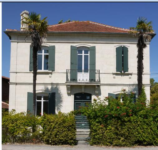
**Particularités :** Cette maison à deux étages est caractérisée par une symétrie axiale des éléments de sa façade (ouvertures, toiture et moulures). Un perron permet l'accès à une grande porte en bois sculptée. Le perron est abrité par un balcon dont le garde-corps est en fer forgé. Les murs sont enduits et marqués par des moulures, autour des ouvertures et en saillies horizontales. Une corniche sculptée s'insère sous la toiture à 2 croupes, en tuiles de Marseille.
