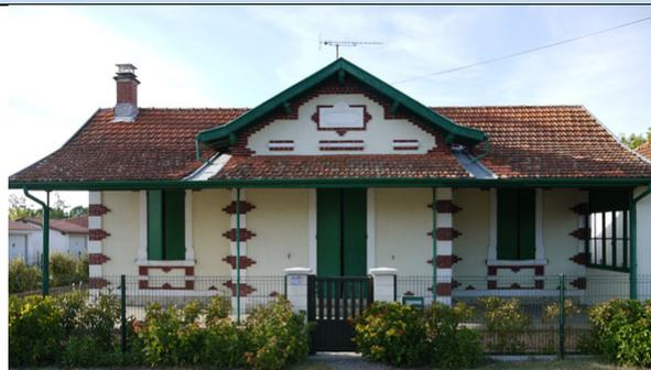
**Particularités :** Le bâti comprend un retour en équerre central, surmonté d'une lucarne à fronton. La toiture principale, composée de tuiles de Marseille, est à 2 pans. Les débords de toiture des pignons sont tenus par des éléments de charpente sculptés et peints de la même couleur que le bandeau en bois. Une rupture de pente en façade marque le retour du bâti et une galerie à colonnettes de fonte.
