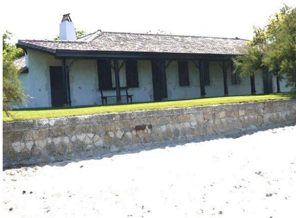
**Particularités :** Le plan d'ensemble compose une façade en longueur en retrait de la plage. La façade, longée par une galerie à piliers de bois, est rythmée par l'espacement régulier des ouvertures. Les ouvertures sont encadrées par des appareillages de pierres. Aucune clôture ne sépare le jardin de la plage.
