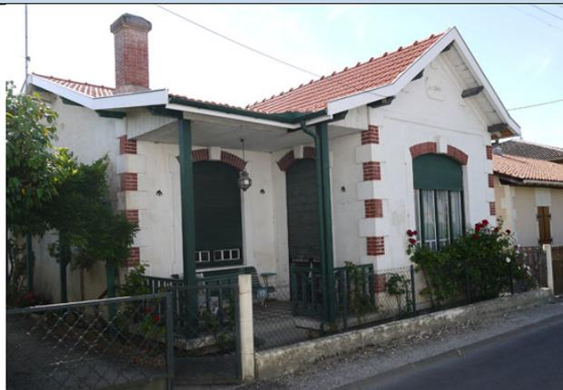
**Particularités :** La toiture, en tuiles de Marseille, est à 2 pans avec un retour de pignon latéral sur la façade. Les débords de toiture sont soulignés par des éléments de charpente apparents peints et sculptés.
