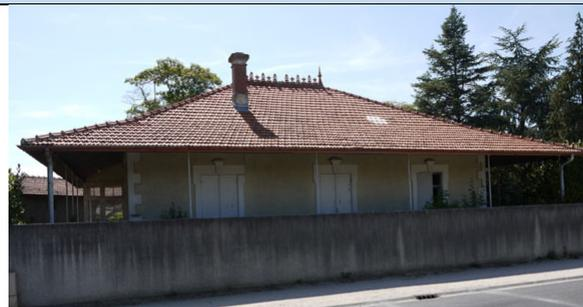
**Particularités :** Bâti de volume simple proche de la rue, en léger retrait. La toiture à 2 croupes, composée de tuiles de Marseille, est surmontée d'une crête de faitage. Une galerie à colonnettes en fonte entoure la maison sur deux côtés. Les murs sont revêtus d'un enduit clair et de chainages de pierre dans les angles. Des moulures font le tour des ouvertures. Un mur opacifiant gêne la lisibilité de la façade.
