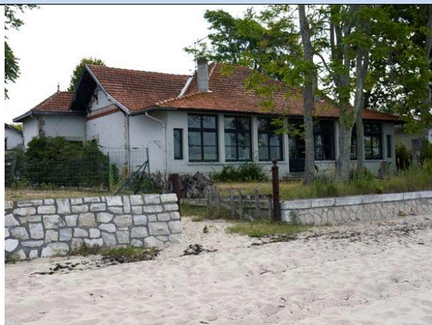
**Particularités :** La galerie en façade littorale est reconvertie en verrière à carreaux carrés. La villa est couverte d'une toiture à retour de pignon latéral et rupture de pente en façade. La toiture est recouverte par des tuiles de Marseille. Des éléments de charpente apparents soutiennent le débord de toiture du pignon latéral. Aucune clôture ne sépare le jardin de la plage. Un alignement de frênes remarquables longe le perré et participe au front boisé du littoral.
