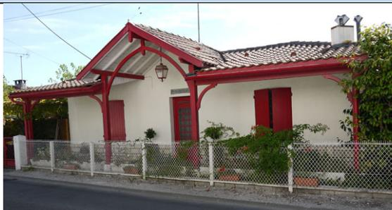
**Particularités :** La toiture à 4 pans se caractérise par un retour de pignon central en façade. Des jambes de force en bois peint soutiennent les débords du toit. Aucun élément décoratif n'est visible sur le mur de façade. La transparence de la clôture permet la continuité des espaces extérieurs avec la rue.
