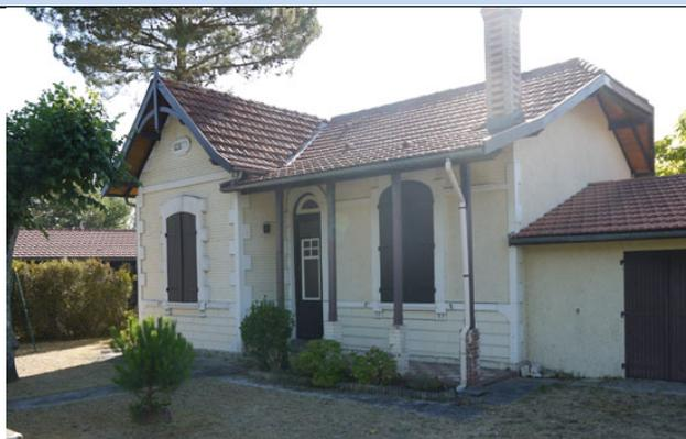
**Particularités :** La toiture, en tuiles de Marseille, est surmontée d'une haute souche de cheminée appareillée de brique. Les débords de toiture du pignon et de la demi-croupe sont tenus par des éléments de charpente apparents sculptés. Une galerie à piliers de bois s'insère sous la rupture de pente du toit.
