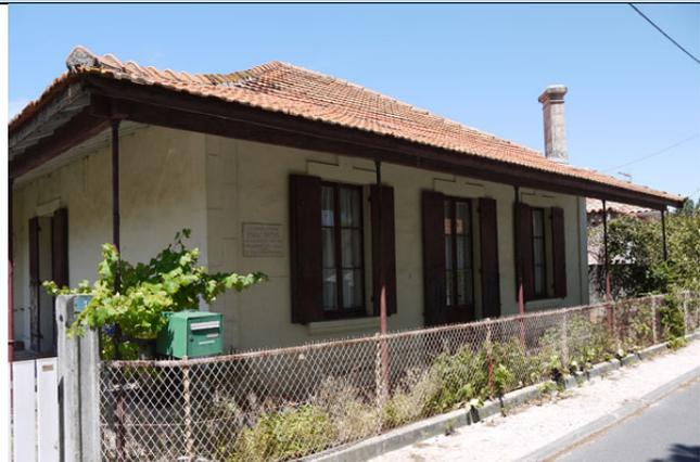
**Particularités :** La toiture à quatre pans est recouverte de tuiles de Marseille et repose sur des colonnettes en fonte.
