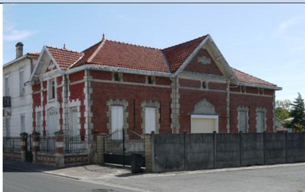
**Particularités :** Cette maison est caractérisée par une symétrie des éléments de ses deux façades (ouvertures, toiture et murs). La toiture à 2 croupes est en tuiles de Marseille et surmontée d'épis de faitage. Deux entrées (une sur chaque façade) sont surmontées d'un retour de pignon.
