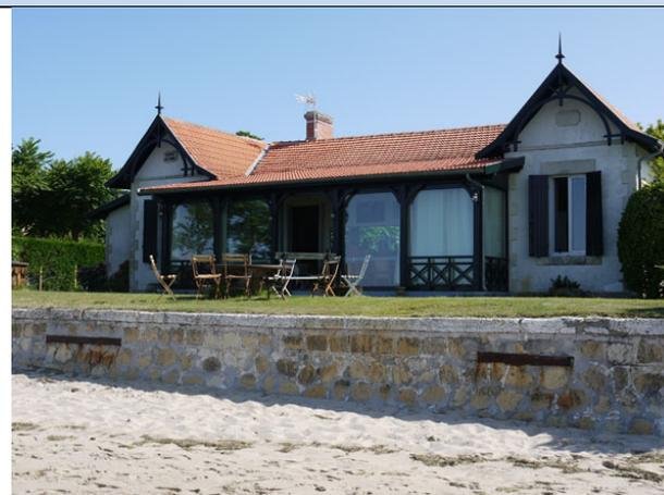
**Particularités :** La façade est flanquée de deux retours de pignons latéraux. La galerie centrale est reconvertie en verrière en baie vitrée. Les débords de toiture des pignons latéraux sont soulignés par des éléments de charpente apparents décoratifs. La toiture est recouverte par des tuiles de Marseille. La souche de cheminée est composée d'un assemblage de briques. Aucune clôture ne sépare le jardin de la plage.
