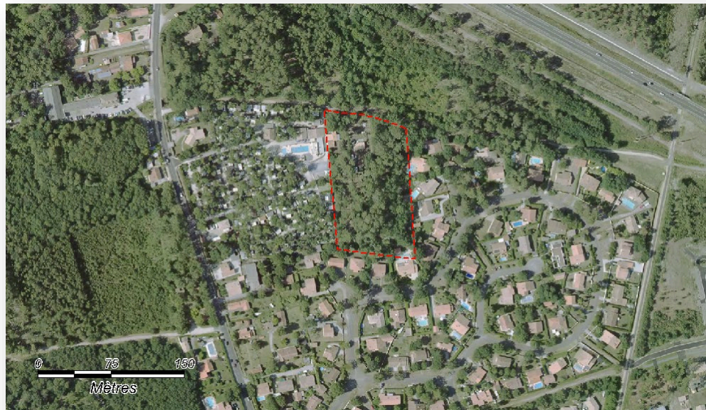
Vue aérienne du site de Perrey Nord
